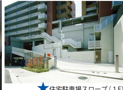
★ 住宅駐車場スロープ(1F)
