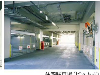
住宅駐車場(ピット式)
