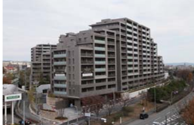
▲再建施行マンション竣工
