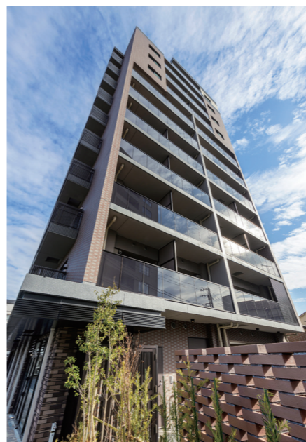
外観 北西面 見上げ
