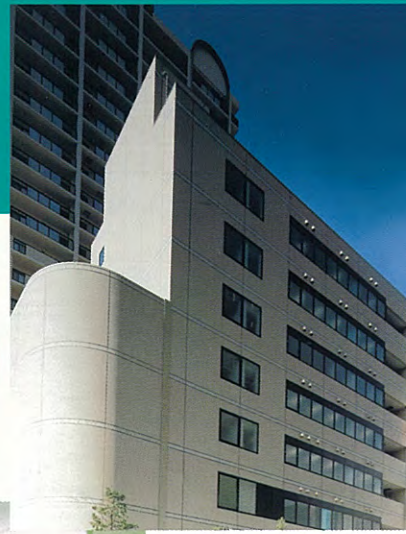
東側別棟業務系ビル
