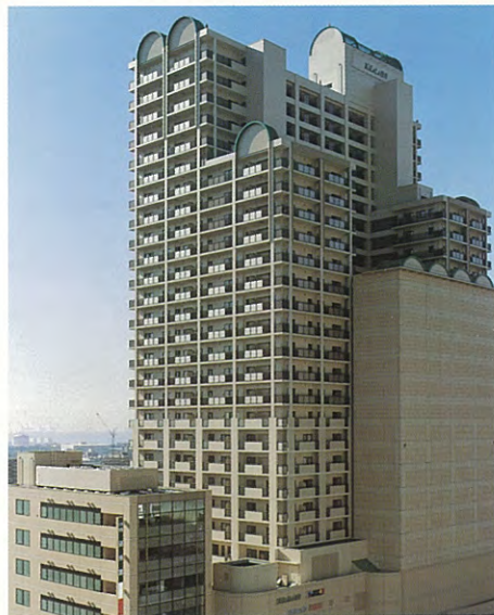
駅側からビルを望む
