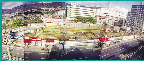
平成10年 施設建築物工事着工前 仮設店舗全景、及び埋蔵文化財調査
