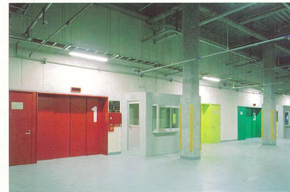
カラフルな彩りの立体駐車場
